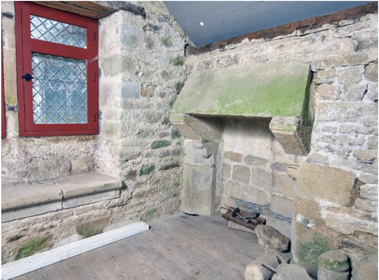
Coussiège et cheminée à l'étage de la sacristie
