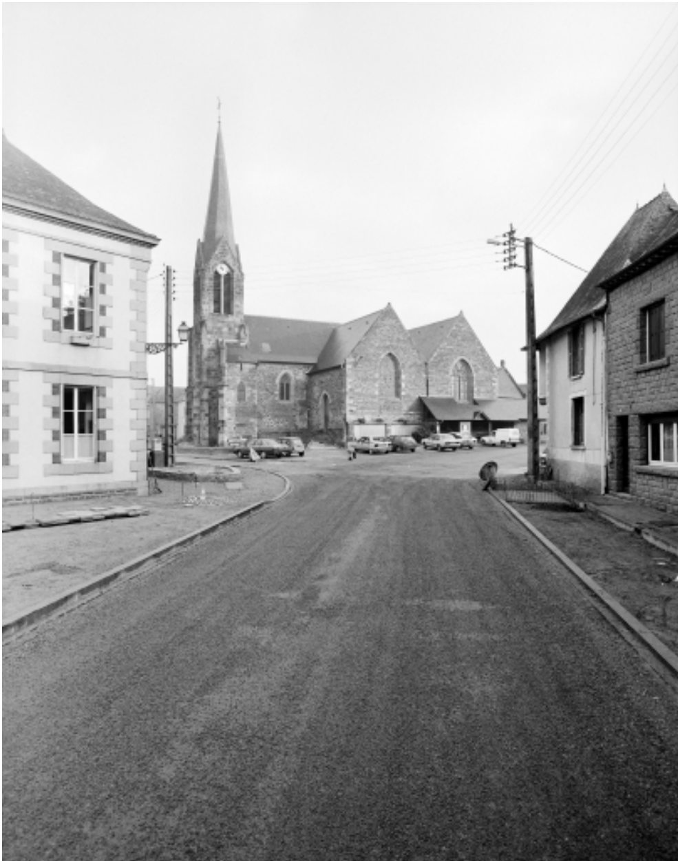
Elévation sud : vue générale
