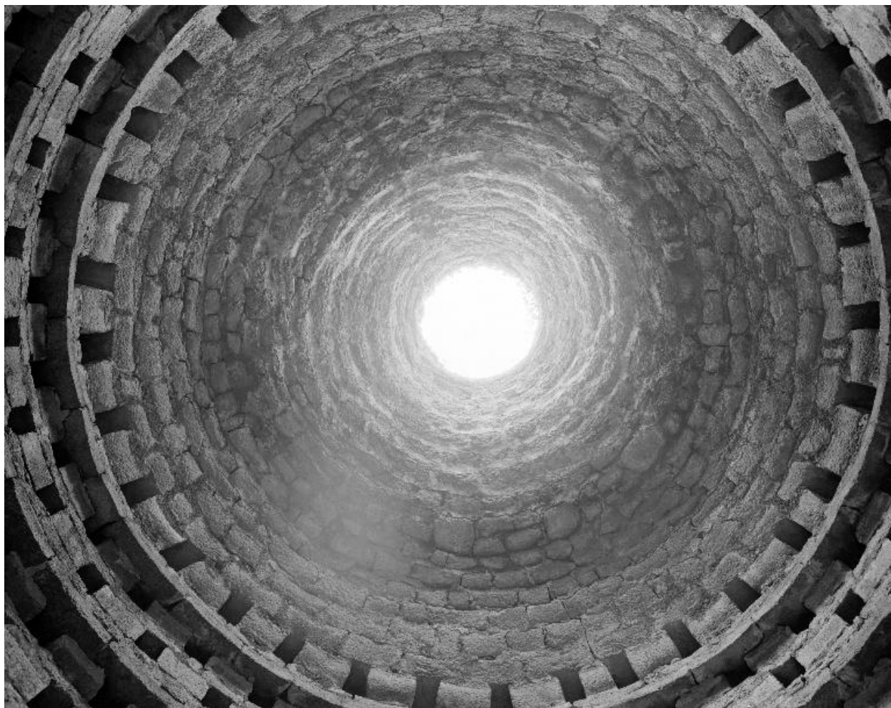
Colombier, vue intérieure.
