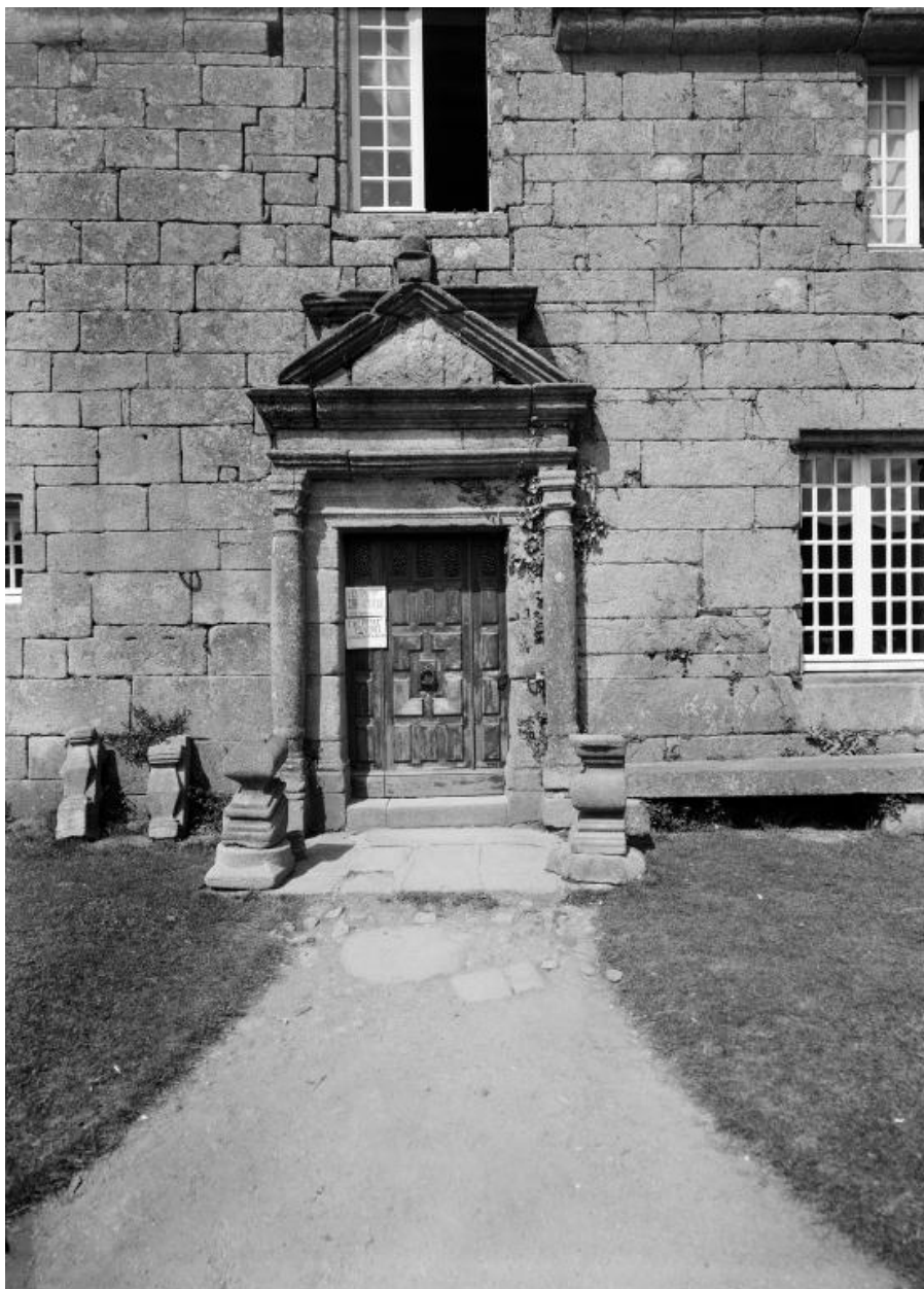
Détail de la porte de la travée
