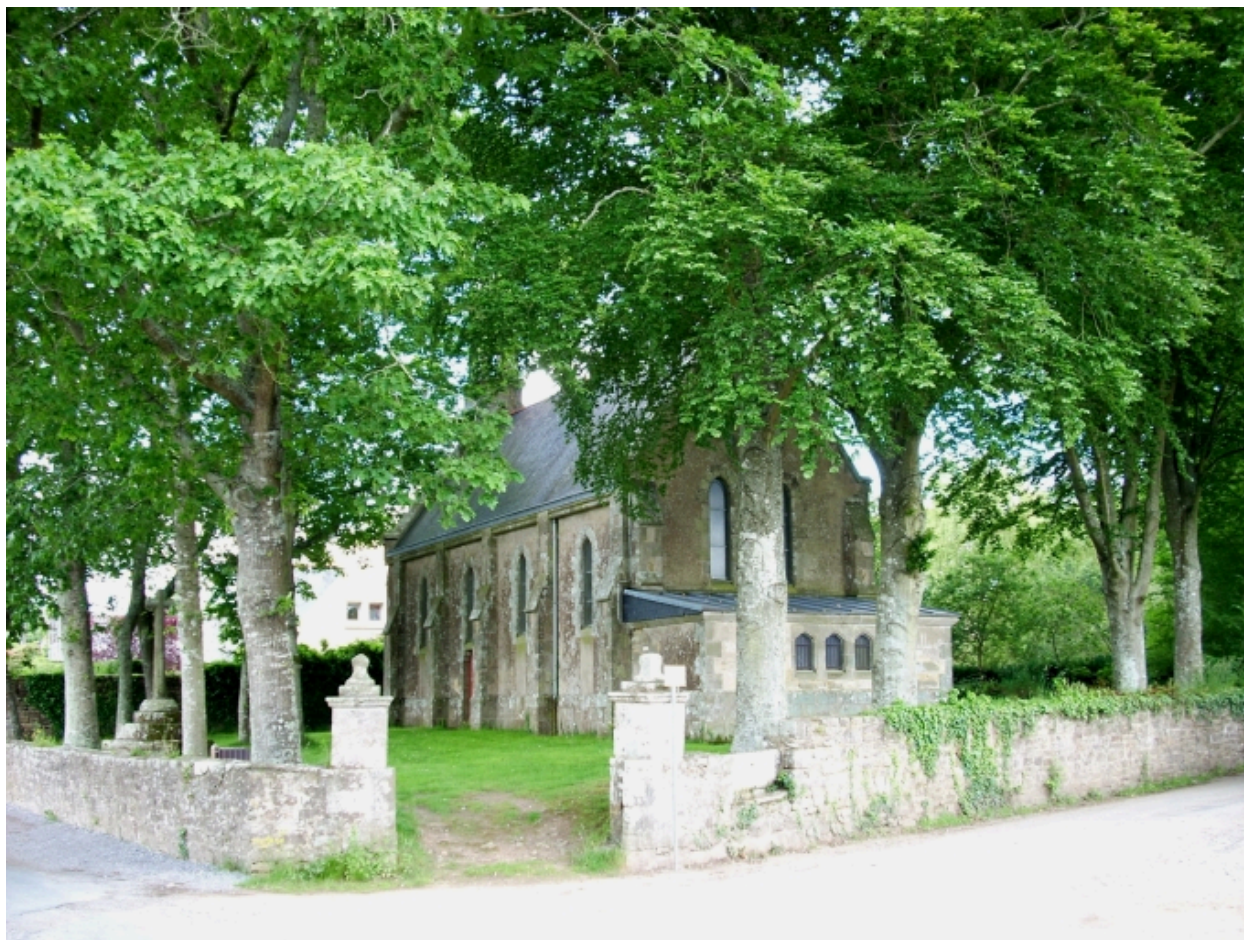
Quimper, chapelle de Cuzon : vue générale sud-est
