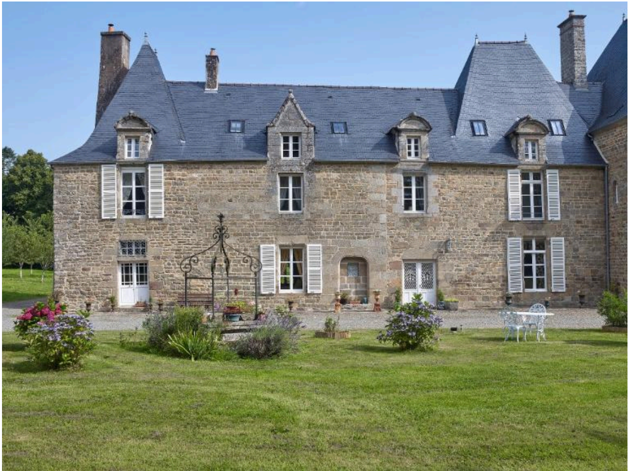
Façade antérieure, détail du corps central et des deux pavillons du 17 e siècle.
