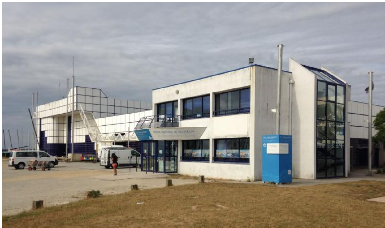
Vue générale prise du nord-est
