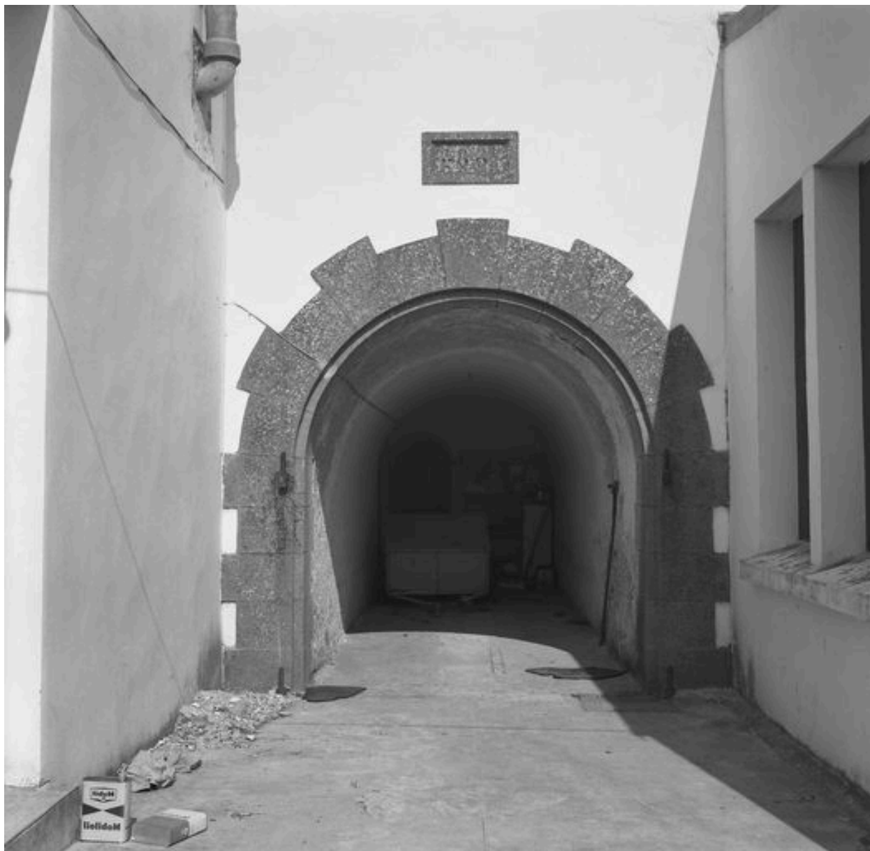
Vue de l'entrée du magasin à poudre daté de 1884 (état en 1969)
