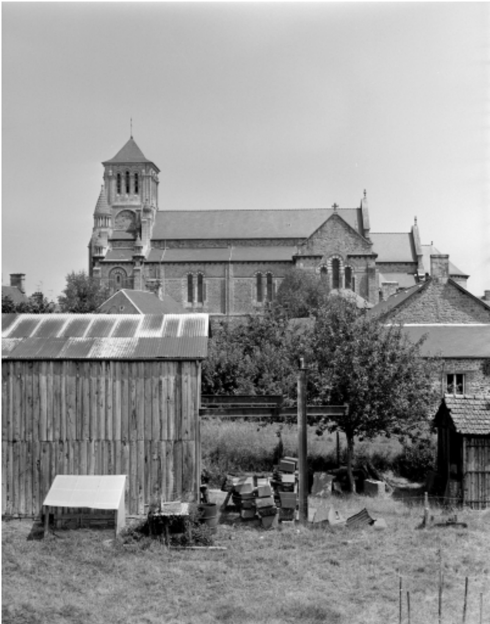
Elévation Ouest : vue générale
