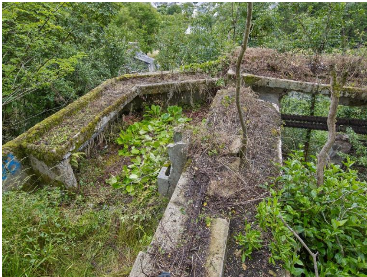
Vue de la serre située au Sud : rez-de-chaussée, bacs de culture en faux bois
