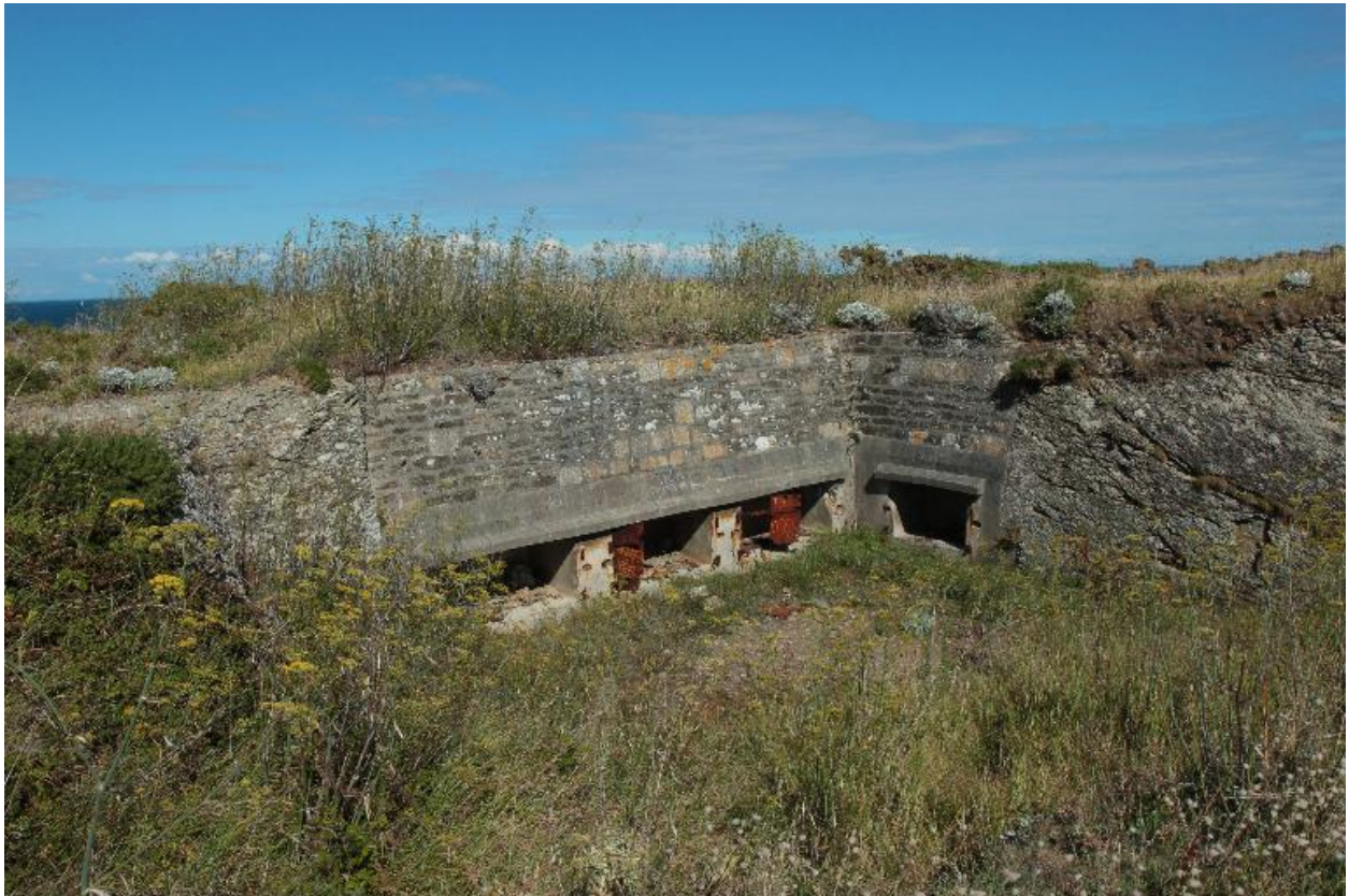
Le Palais, pointe de Taillefer, batterie de 138 mm, niches à munitions.
