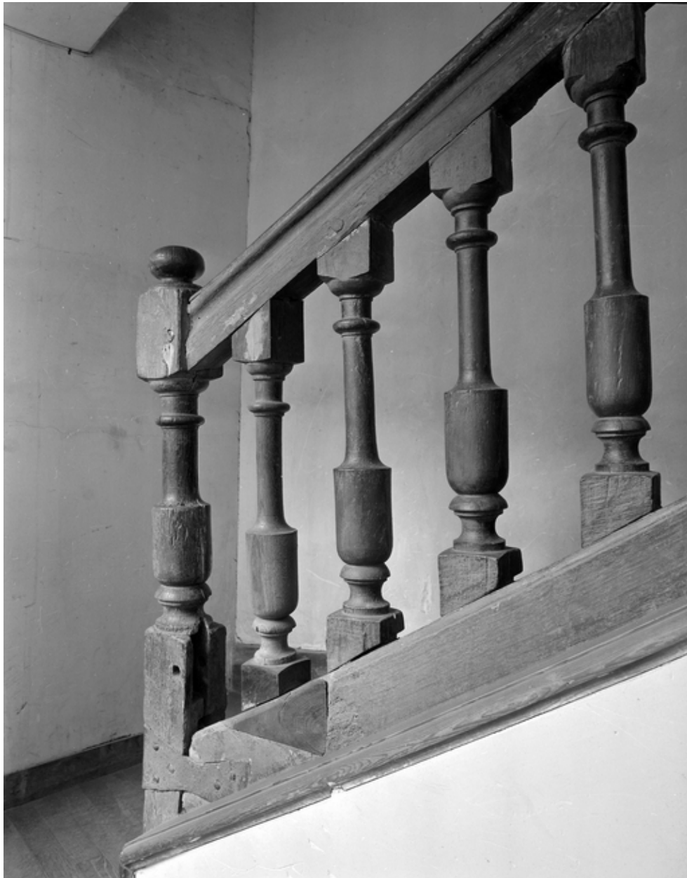
Escalier du corps latéral droit, vue de détail de la rampe.
