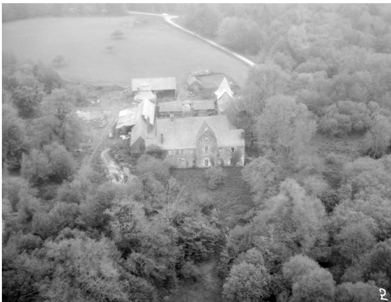
Vue aérienne : vue générale nord
