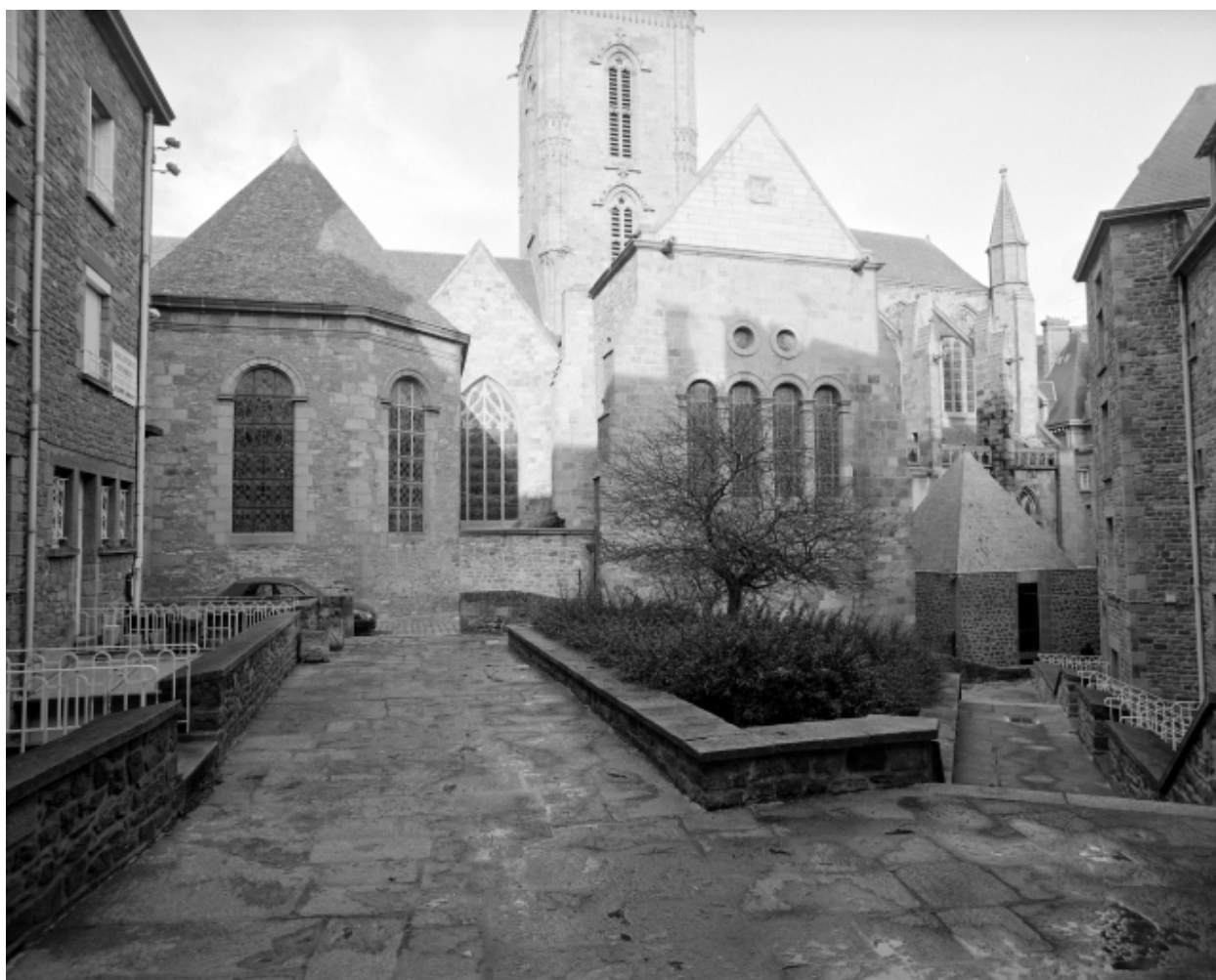
Elévation Sud : vue générale
