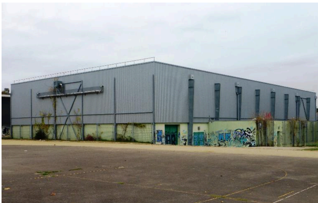
Salle Colette Besson vue du sud-est
