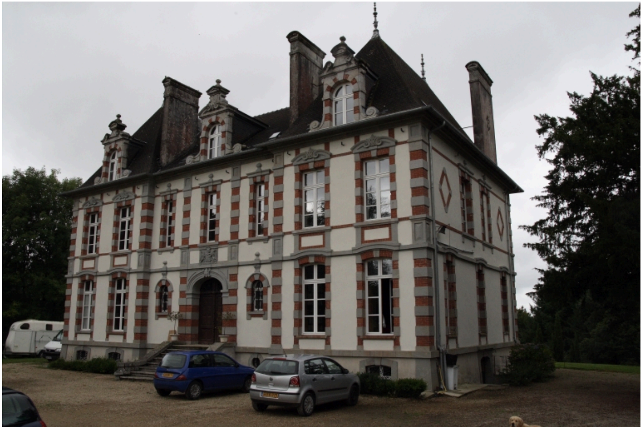
Vue générale nord-est
