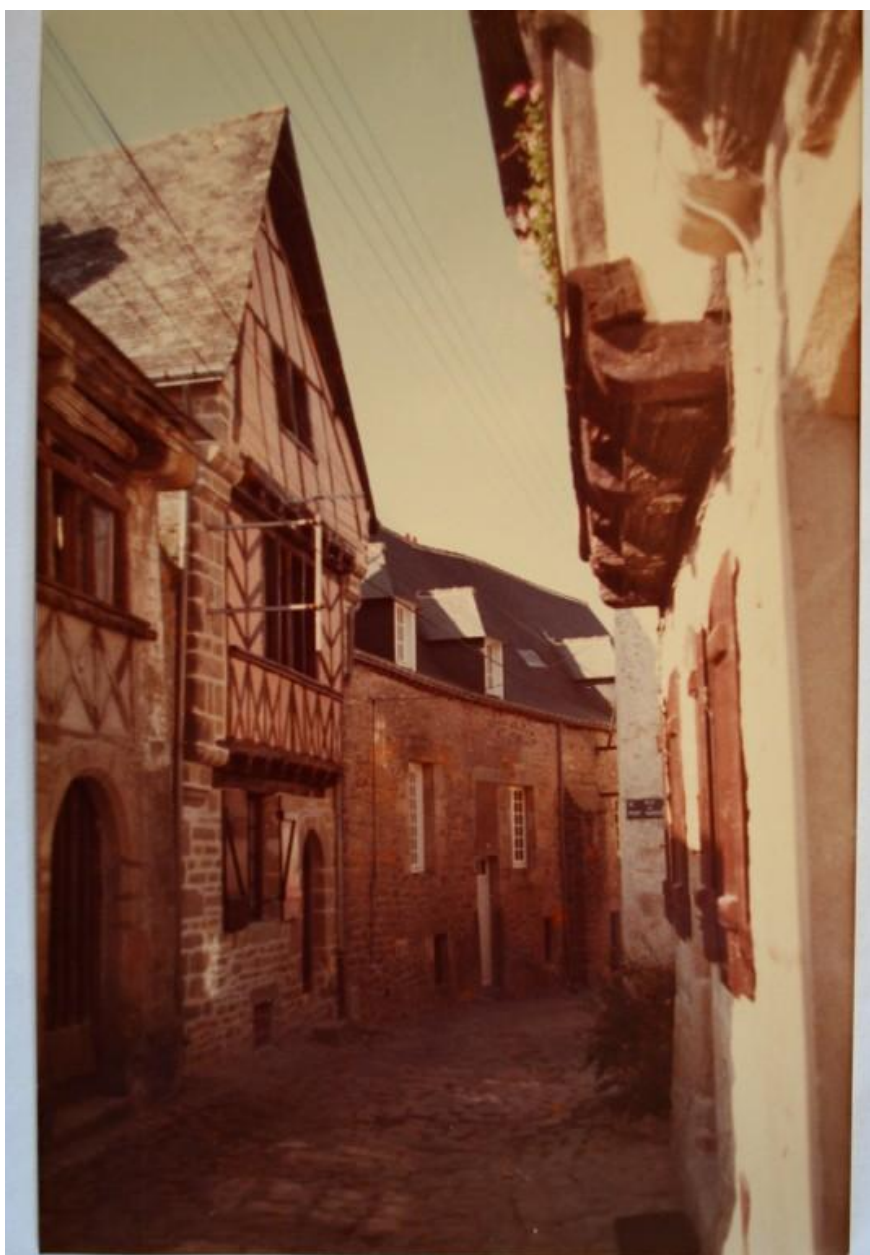
Maison du 4 rue du Petit Port après sa restauration au début des années 1980.
