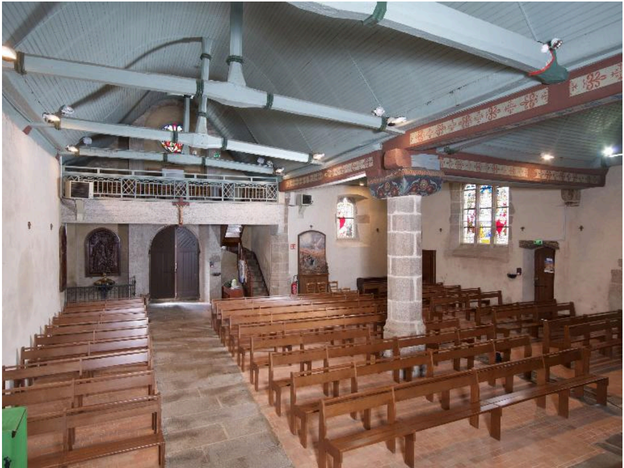
Vue générale de la nef
