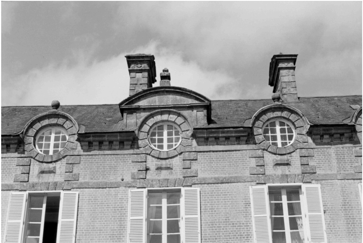
Détail des ouvertures
