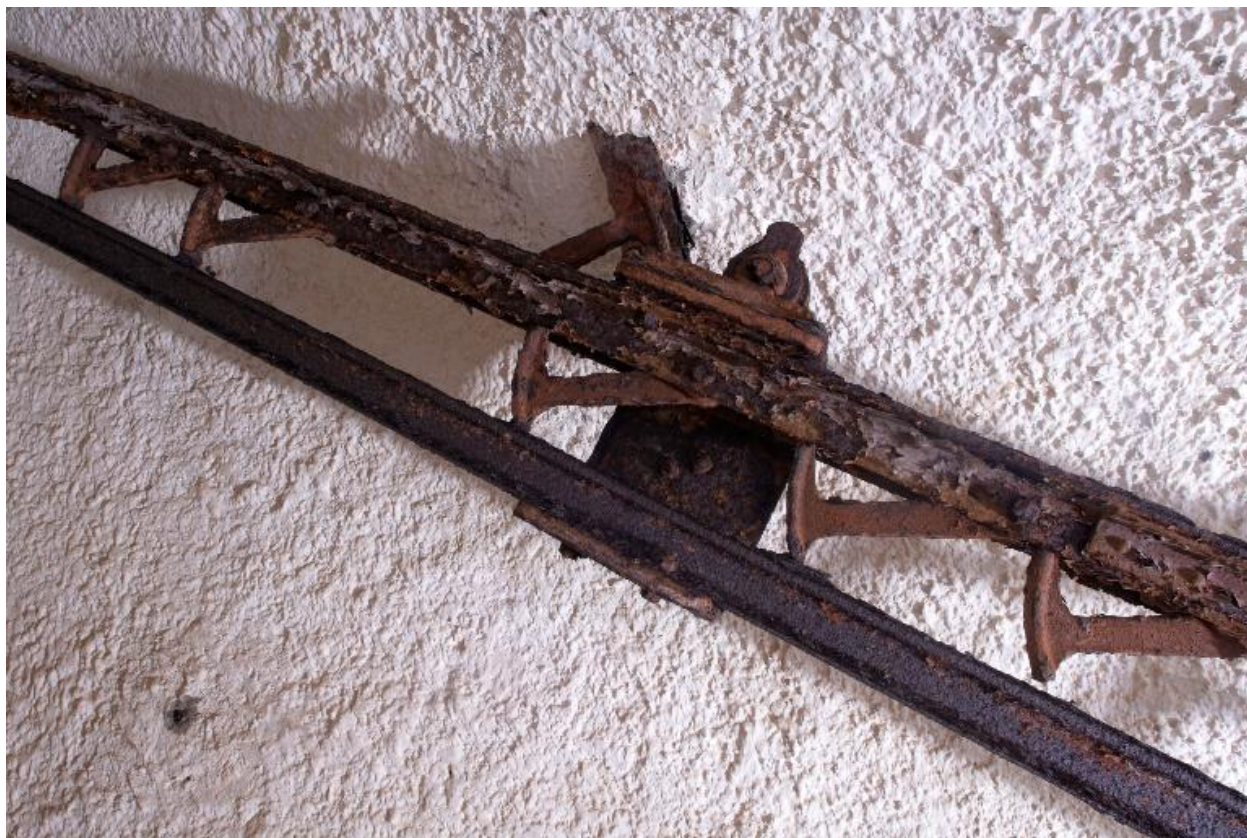
Camaret, pointe du Toulinguet : magasin à poudre sous roc (construction vers 1892), escalier d'accès et monorail élévateur
