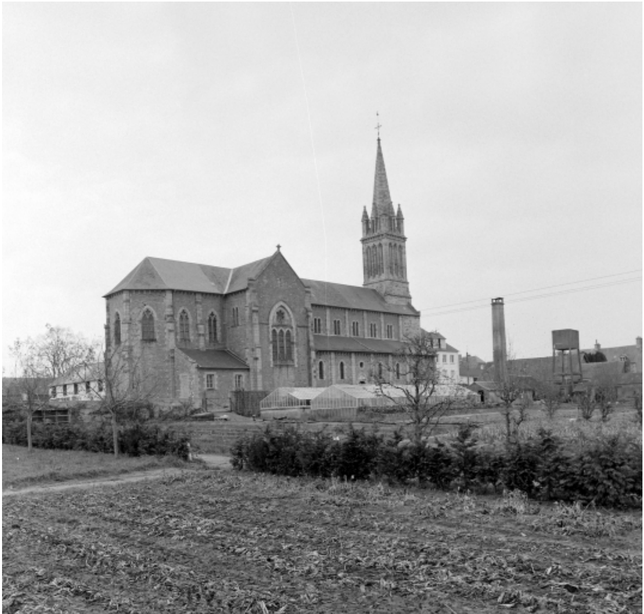
Elévation Sud-Ouest : vue générale
