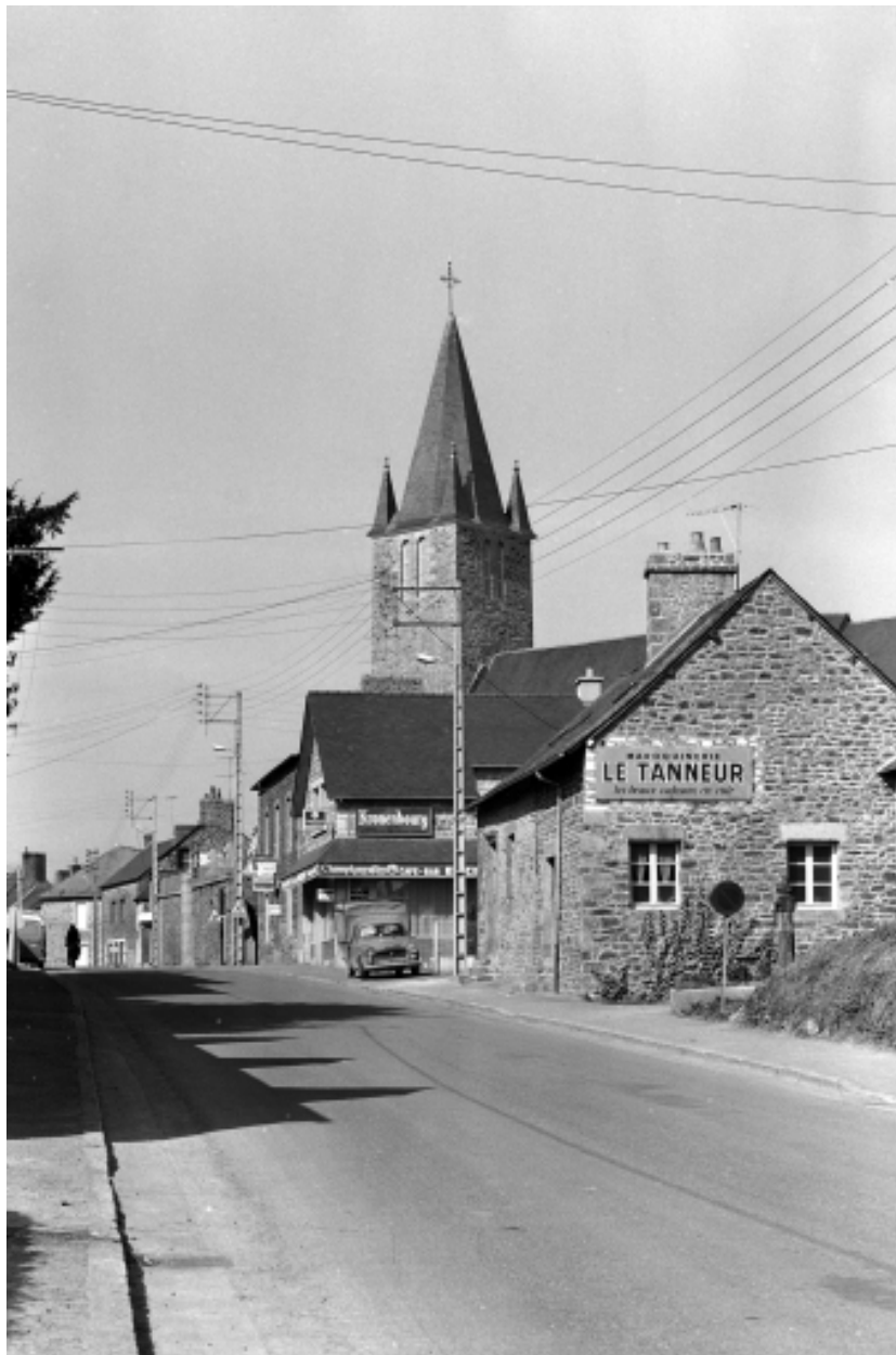
Elévation sud-est : vue de situation
