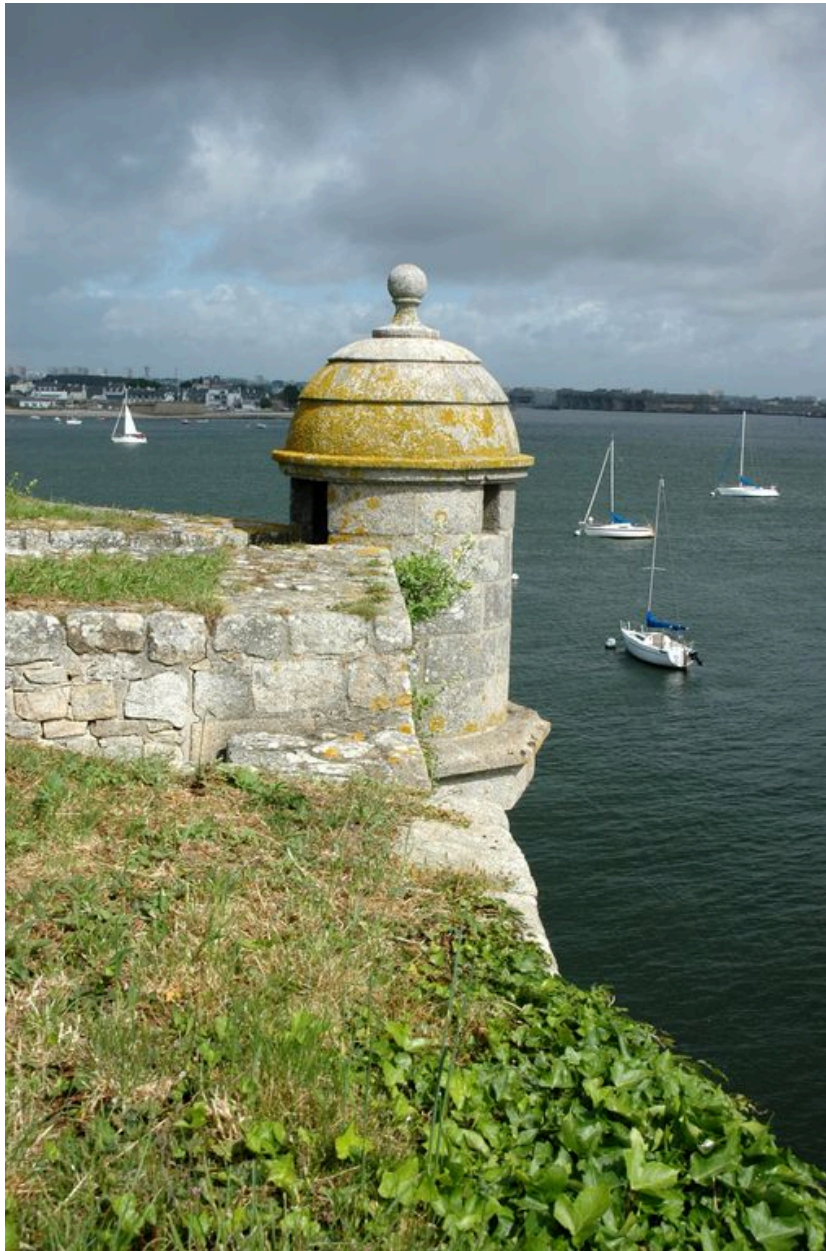
Vue de la citadelle de Port-Louis : bastion de la Brèche, embrasures plongeantes et échauguette
