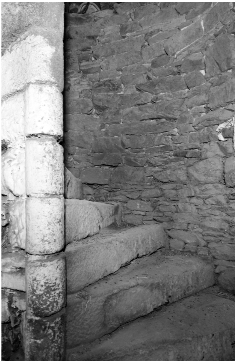
Vue de l'escalier principal en vis
