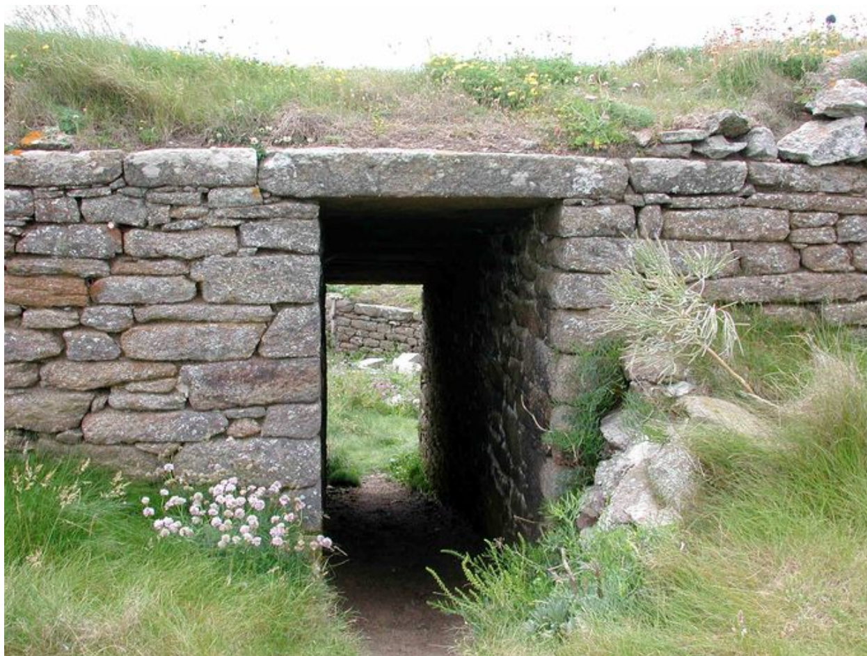
Vue de la galerie de communication avec la batterie basse (état en 2006)
