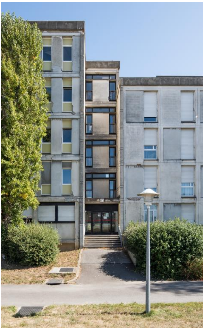
Bâtiment D, façade ouest : cage d'escalier à la jonction entre l'internat de garçons et les logements. Louis Arretche et Jean Lemerrier, architectes, 1967.
