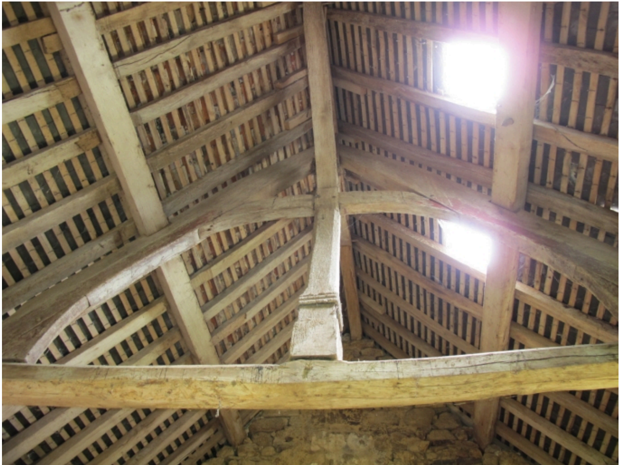
Chapelle : la charpente
