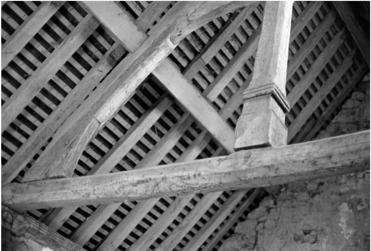
Chapelle : détail de la charpente
