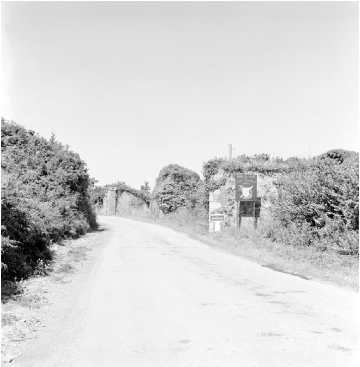
Vue des lignes de Quéléren en 1969 : vestiges de la porte de Crozon
