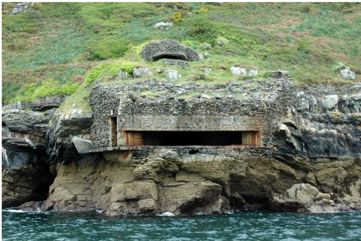
Roscanvel : vue générale du poste lance-torpilles de la pointe Robert. Poste situé au ras de l'eau, à l'ouest de la caserne défensive
