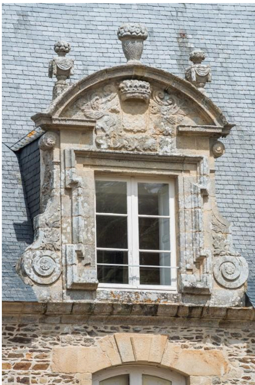
Couronnement de la travée centrale: lucarne armoriée
