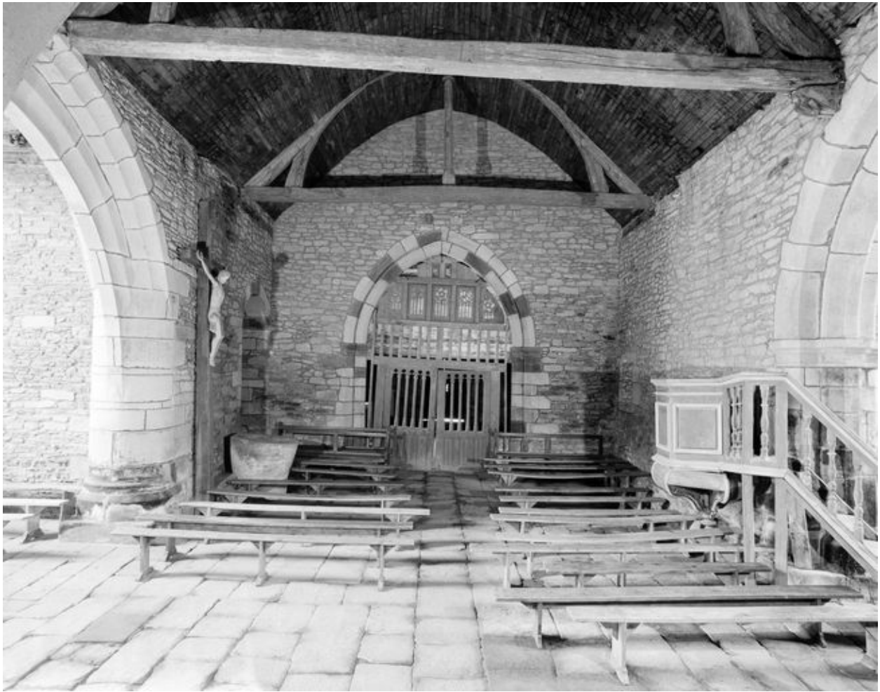
Chapelle : vue générale vers la nef (état en 1992)
