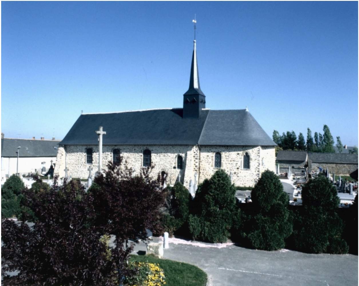
Elévation sud, vue générale.
