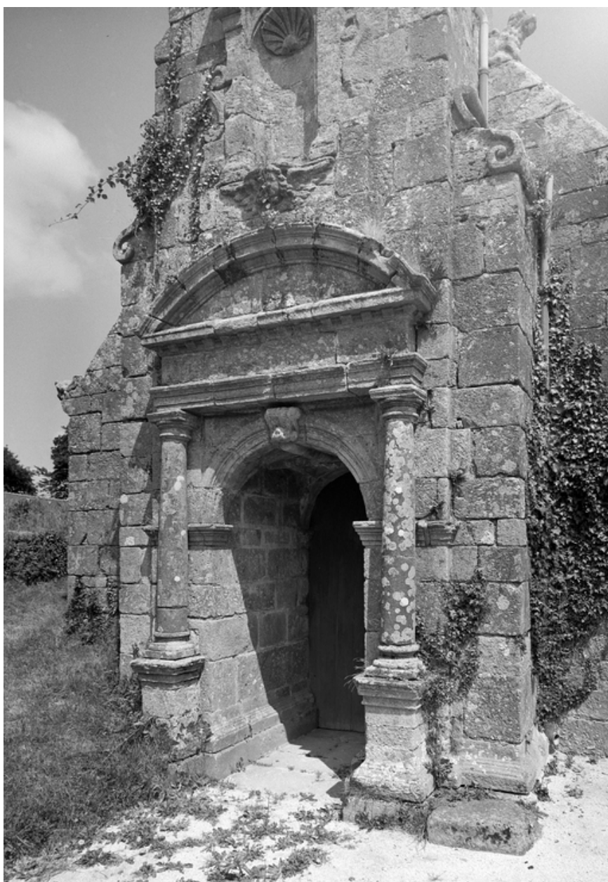
Façade ouest : détail du porche
