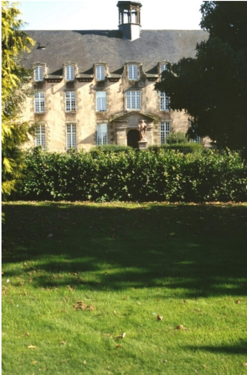
Elévation antérieure : vue partielle.
