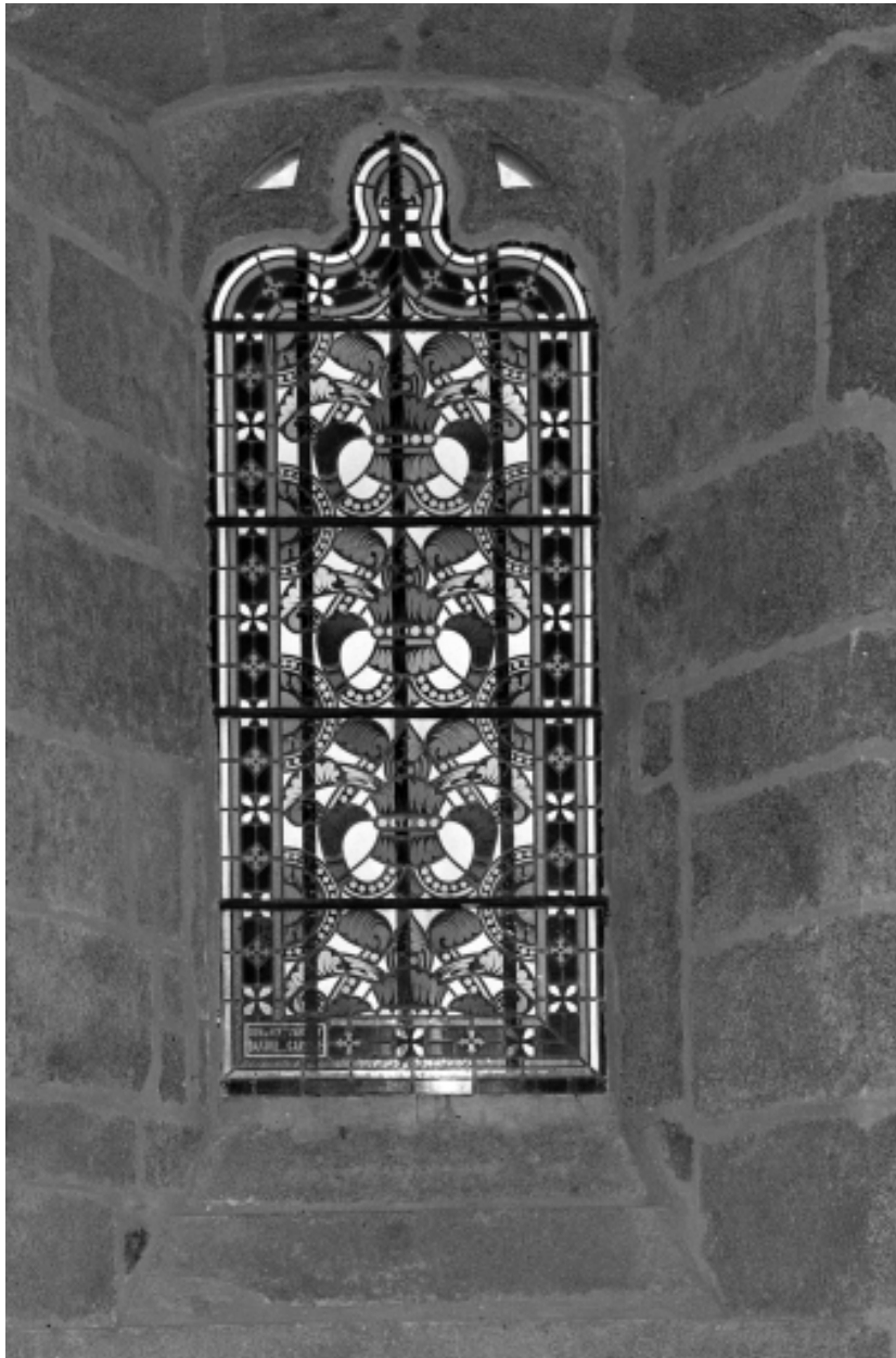
Mur sud, fenêtre 2 et niche, vue générale.
