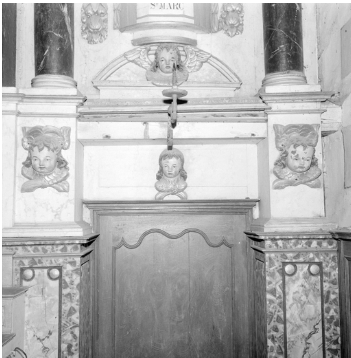
Maître-autel dans le choeur, encadrement et dessus de porte dans l'angle sud-est.
