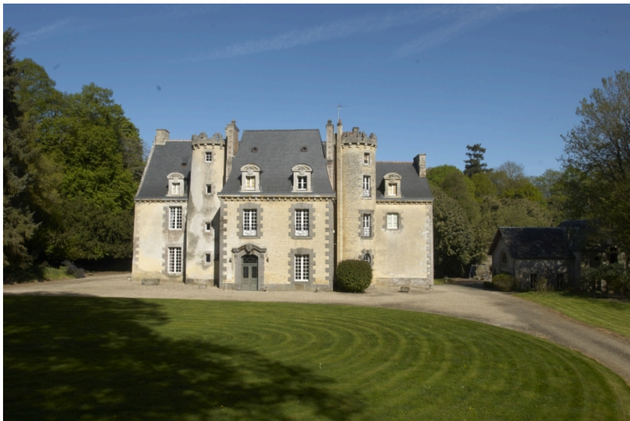
Logis, vue générale de la façade arrière
