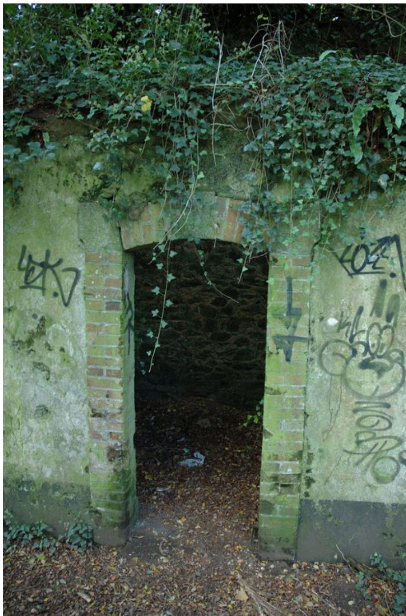
Vue de la caserne : porte avec entourage de brique (état en 2007)
