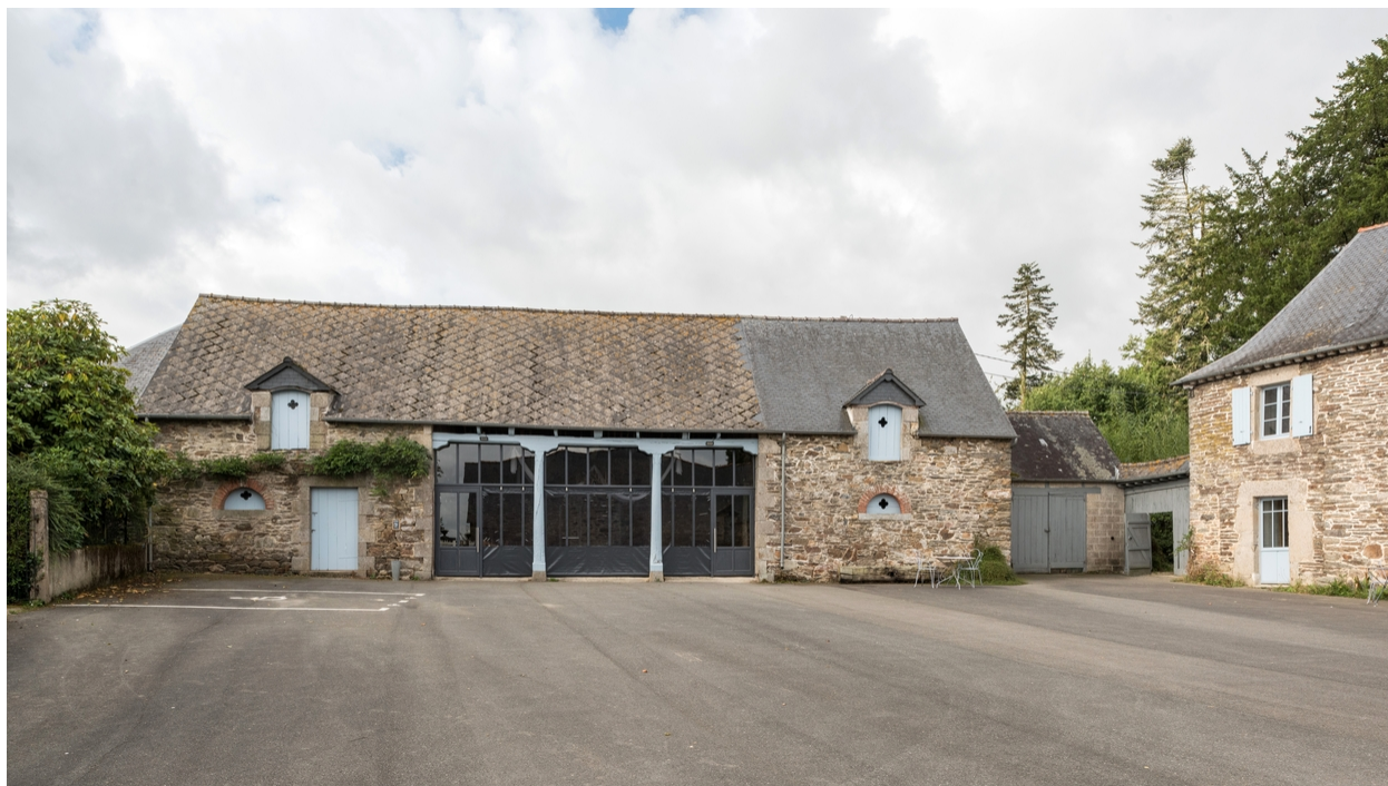
Remise, élévation nord-ouest, vue générale
