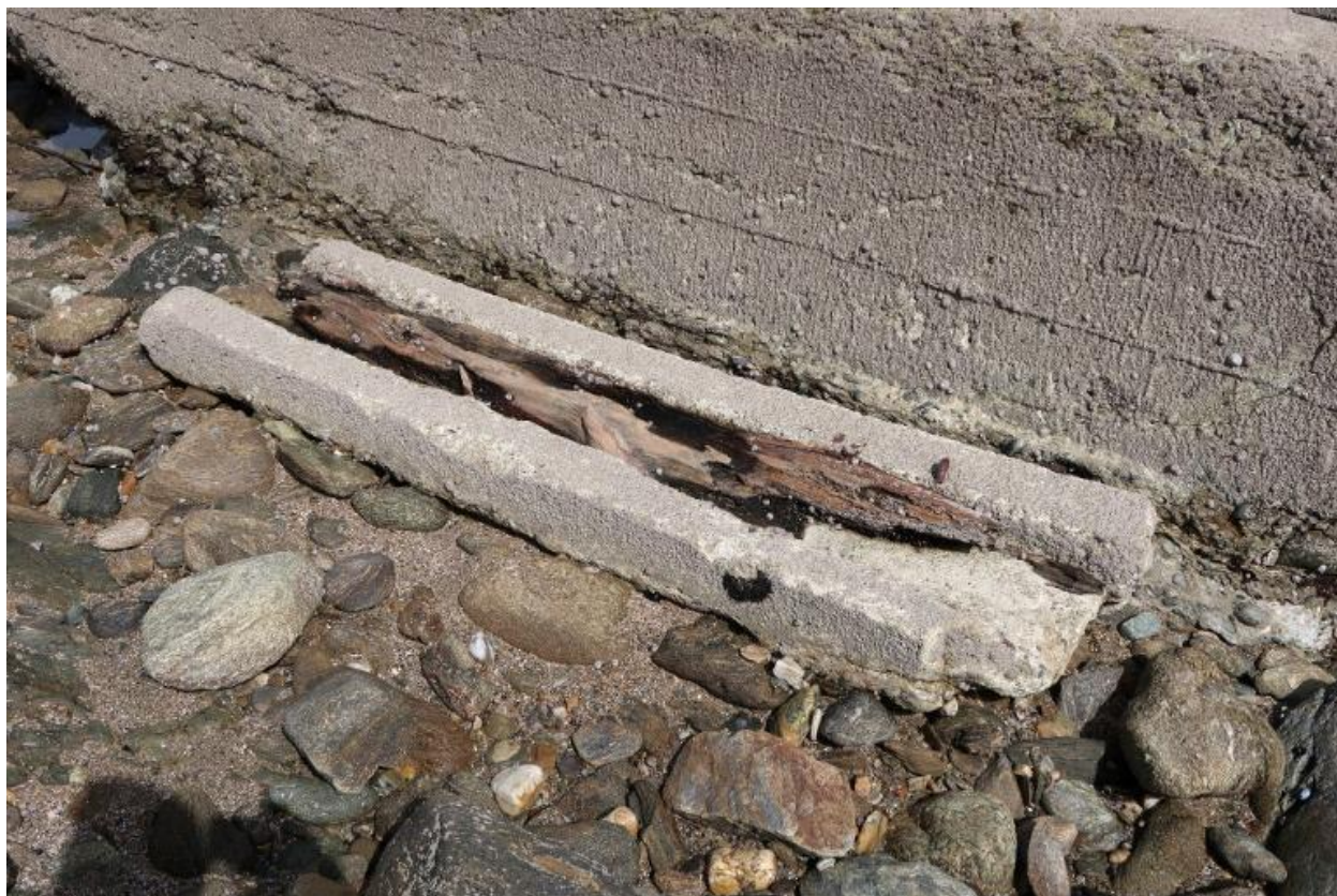
Vue des vestiges de la passerelle
