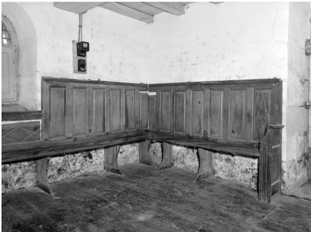
Lambris et bancs contre les murs sud et est de la sacristie.
