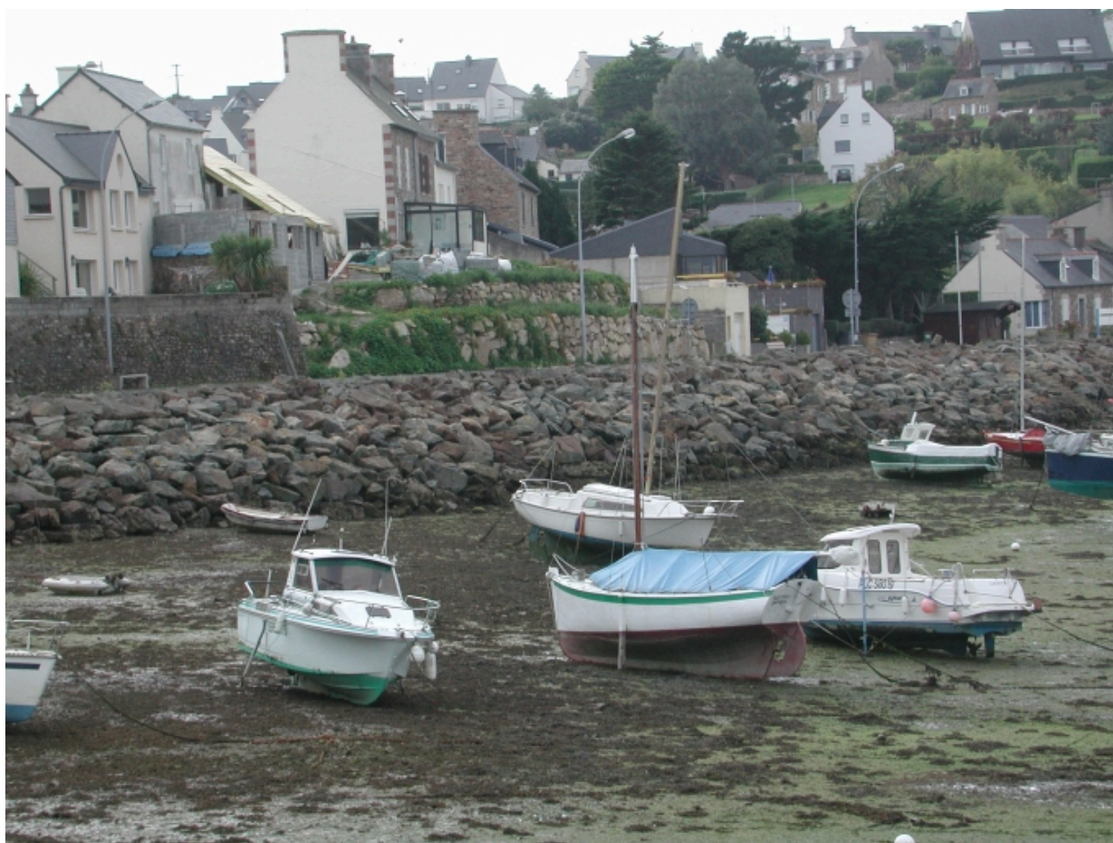
Vue des enrochements qui protègent la partie Est du port
