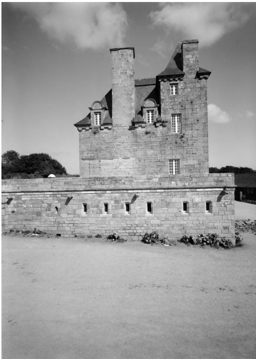
Vue d'ensemble façade ouest
