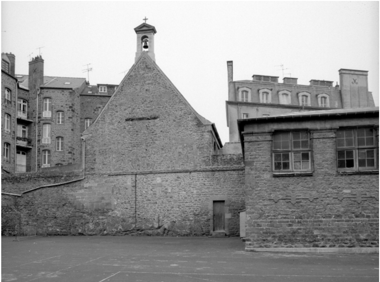
Elévation Est : vue générale
