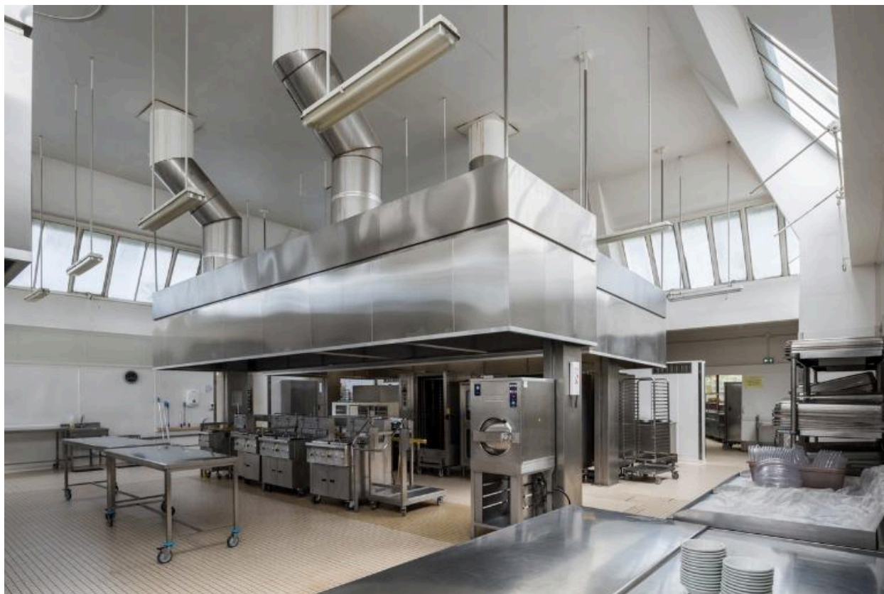
Vue intérieure des cuisines.
