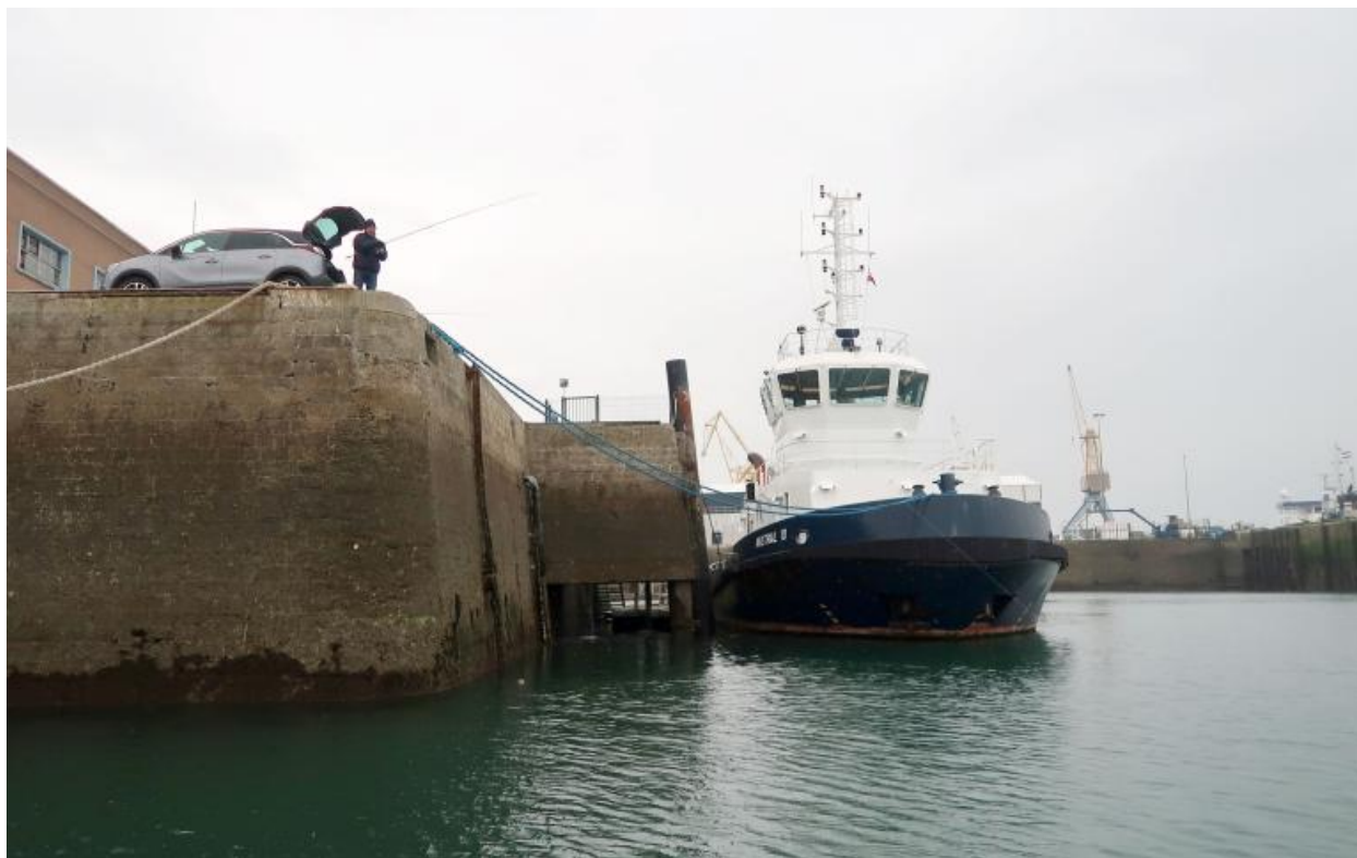
2e éperon, musoir, fonction accostage des remorqueurs
