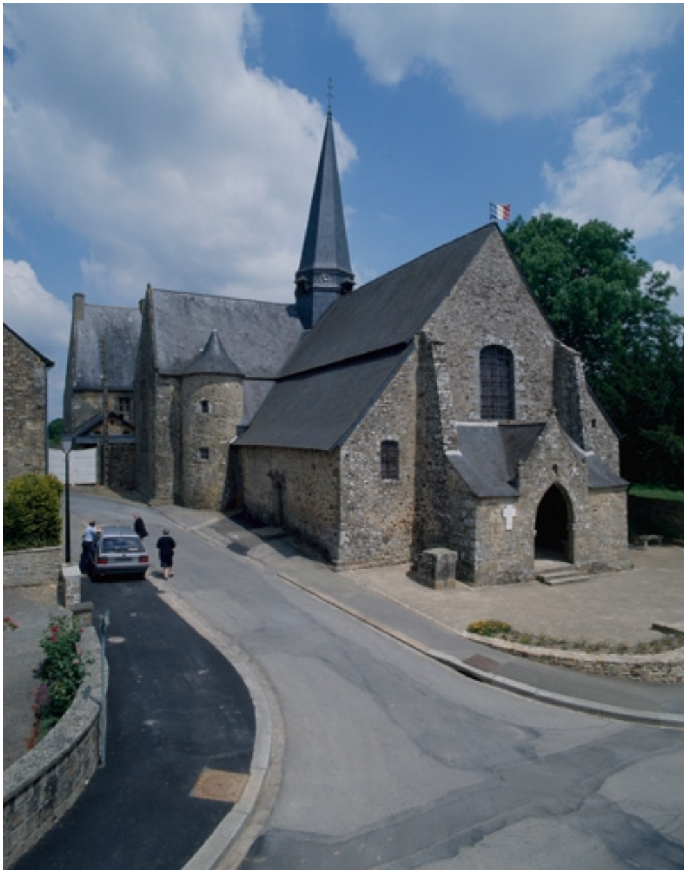
Elévation Nord-Ouest : vue générale
