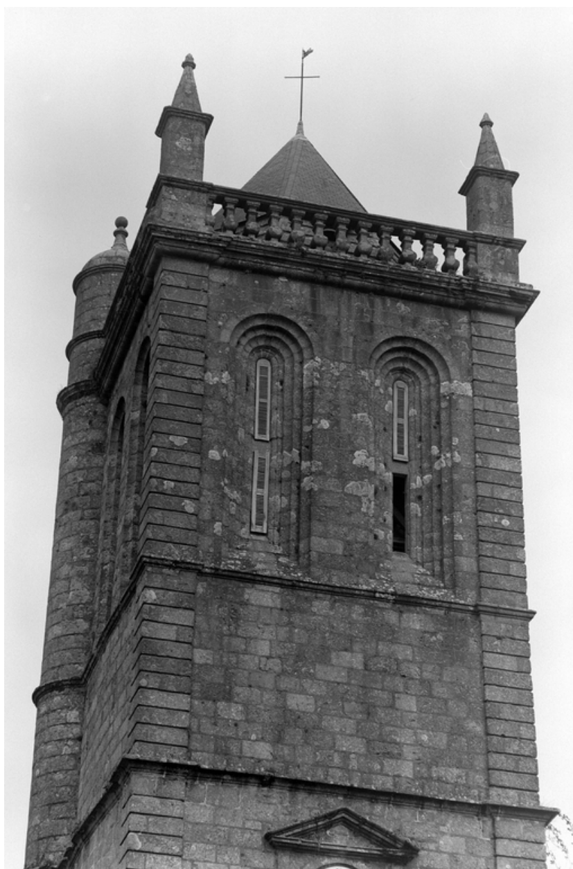
Tour du clocher, face ouest : 3ème niveau et partie supérieure
