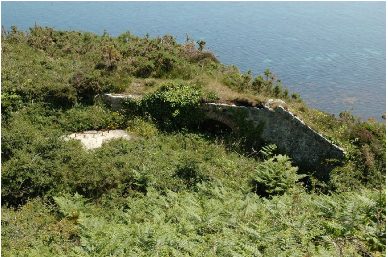
Vue de la batterie de côte pour canon de 95 mm (état en 2005). Elle est envahie par la végétation
